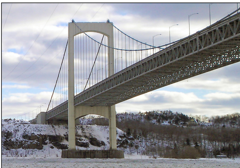
Figure 1-2: Pont routier Pierre-Laporte, Québec city ; Longueur totale : 1041 m ; Portée principale: 668 m ; Hauteur totale: 116 m ; Année : 1966-1970
