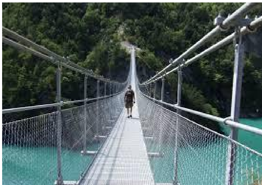
Figure 1-6: Passerelle piétonnière suspendue rigidifiée par des câbles
