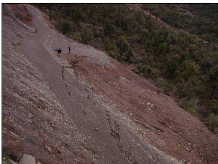
Fig. (1) : Fissures longitudinales dans la route affectée par le glissement
