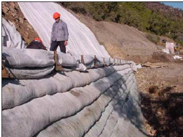
Fig. (3): Construction de l'ouvrage par couches
