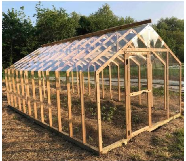
Figure 195 : structure en bois d'une serre bioclimatique
