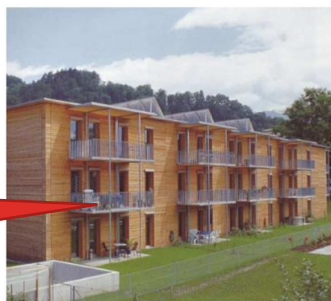
Logement collectif à Dornbirn, Autriche, Hermann Kaufmann Source : L'architecture écologique , Dominique Gauzin Muller
