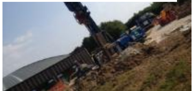
Figure 73 : Pompe à chaleur.
