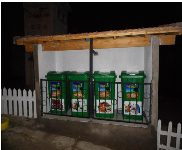
Figure 3 : Niche à poubelles pour le tri sélectif
