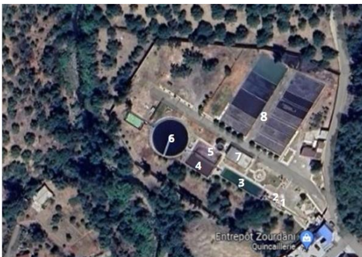
Figure 1.3 : Vue aérienne de la station d'épuration (Google Arth).
