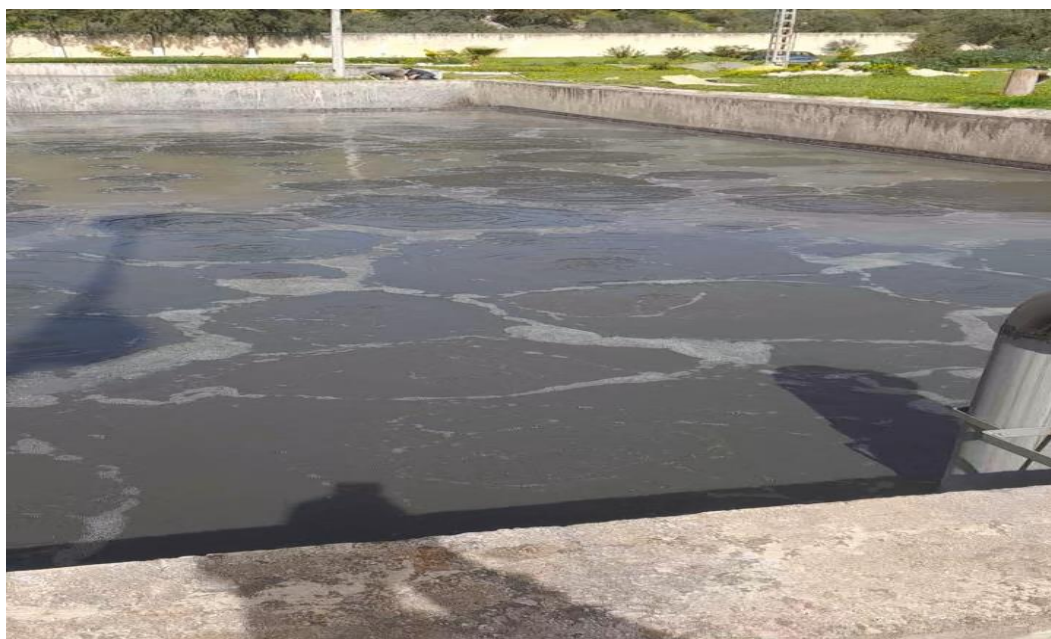
Figure1.9 : Bassin de stabilisation (station de Boghni).
