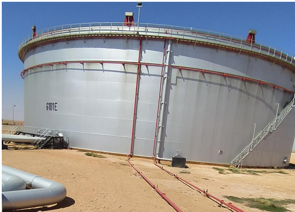
Figure II.16 : Réservoir de stockage de 35000 m 3 destinée au condensat
