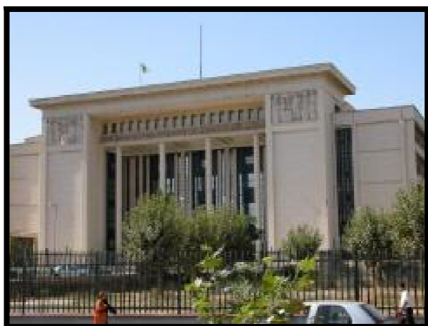
Figure 38: Bâtiment type Moderne Siege de l'UGTA Source : https://www.algeriepatriotique.com/2018/04/28/1er
