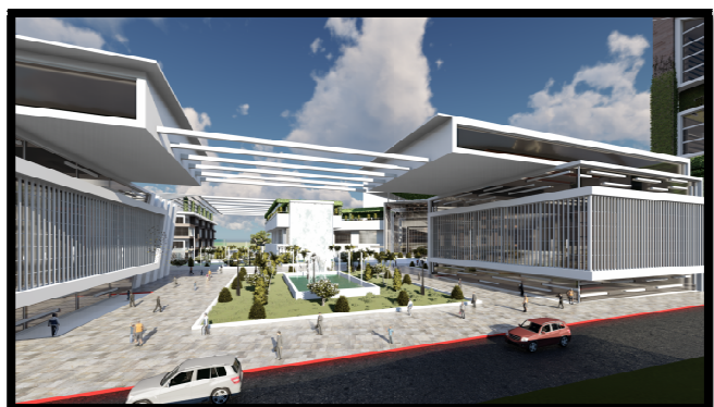
Figure 193 : Les porte-à-faux Source : Auteurs
