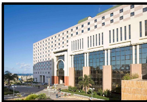
Figure 60: Hôtel SOFITEL Source : Auteurs
