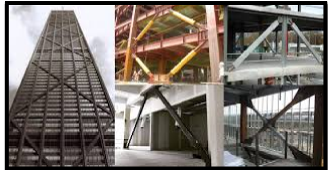
Figure 192 : Système de contreventement Source : https://book4yours.blogspot.com/2020/05/types-des-systemes-de-contreventement-Utilises-Dans-Les-Structures-En-Acier.html
