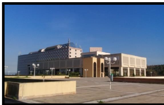
Figure 48 : Hôtel Sofitel Source : Auteurs
