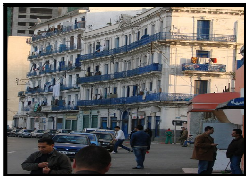
Figure 46: Façade Rue Hassiba Ben Bouali (Style néo classique) Source : Auteurs
