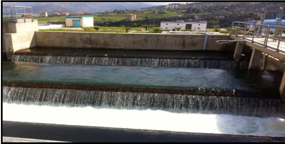
Figure 3. Chambre d'arrivée d'eau brute
