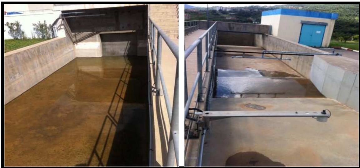
Figure 07 : Canal Parshall partie amont et aval
