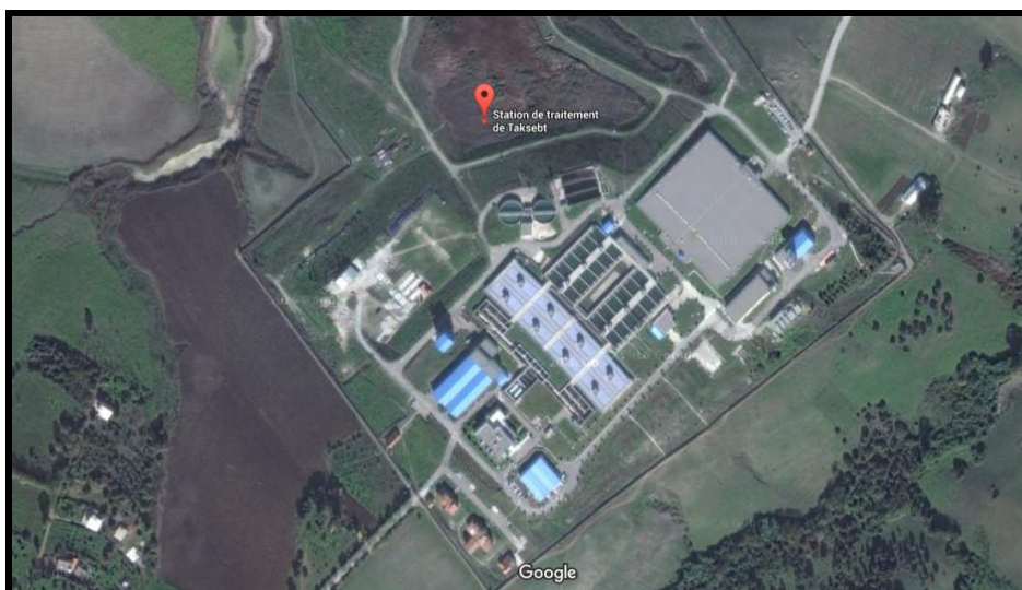
Figure 5. Station de traitement de Taksebt.
