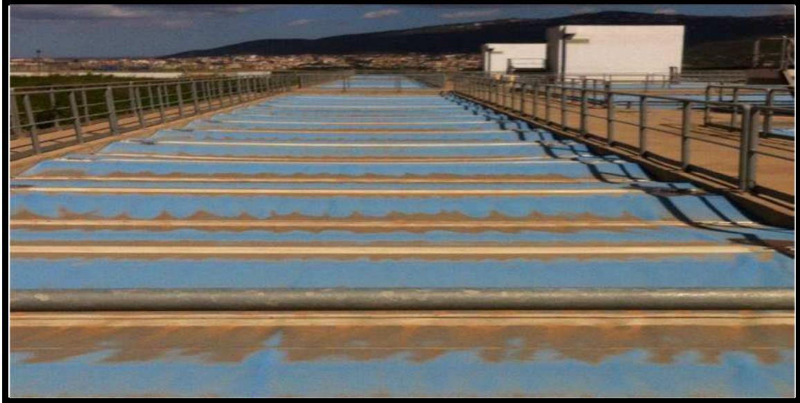
Figure 6. Décanteurs pulsatube
