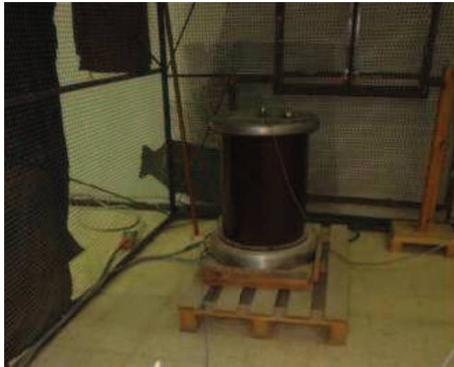
Figure(III.2) : Transformateur d'essais
