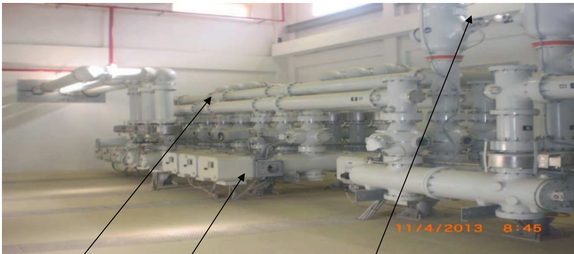
Figure(II.5) : Jeux de barres 60kv dans un gaz SF6
