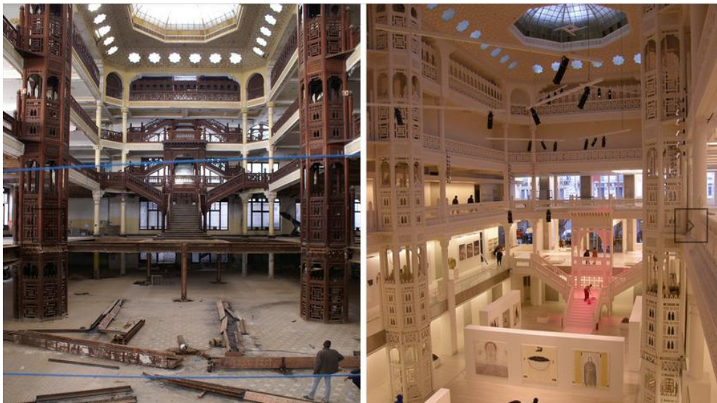
Figure N° 1.28: l'intérieur de musée MAMA avant et après les travaux de réhabilitation Source : https://grupoacerta.com/project
