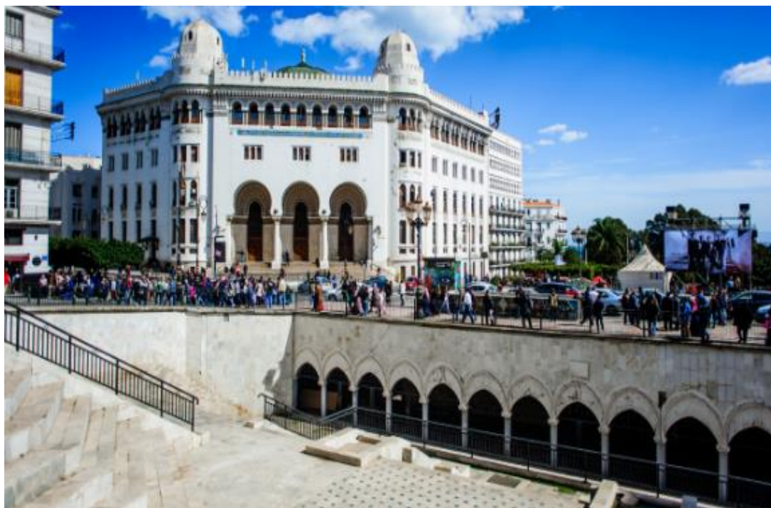
Figure 4.1. Vue sur la Grande Poste d'Alger
