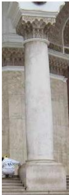
Figure 1.11 : Colonne 1 à fût cylindrique
