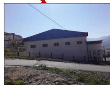
Figure 132 : Salle de gymnase Source : Auteurs
