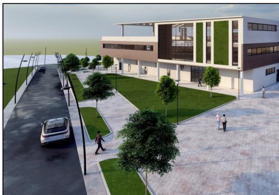
Figure 166 : les accès du côté Nord au projet Source : Auteurs
