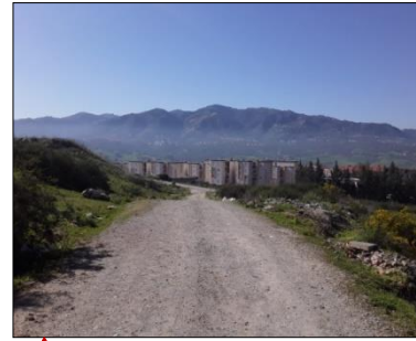
Figure 122 : Accès mécanique Est Source : Auteurs
