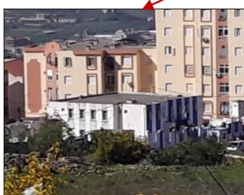
Figure 133 : Garde communale Source : Auteurs
