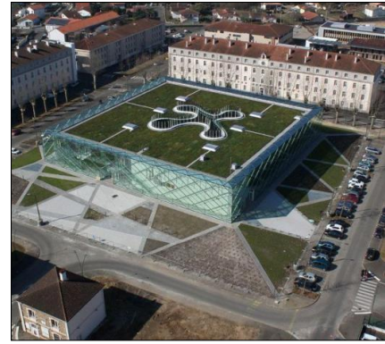
Figure 30 : Médiathèque à Mont de Marsan Vue de l'extérieur
