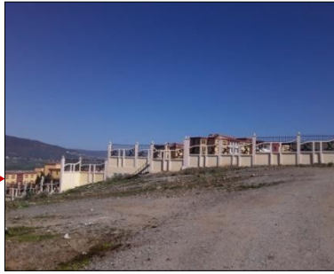
Figure 121 : Accès mécanique Nord-Ouest Source : Auteurs
