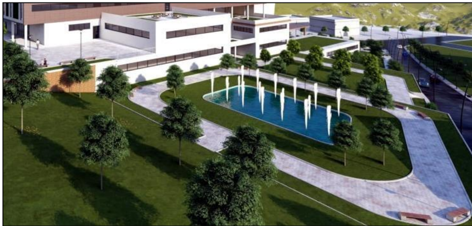
Figure 205 : les espaces extérieurs végétalisés Source : auteurs
