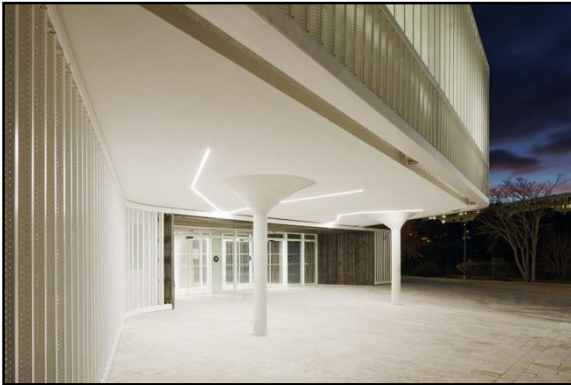
Figure 98 : Structure champignon de l'entrée de l'Hexagone
