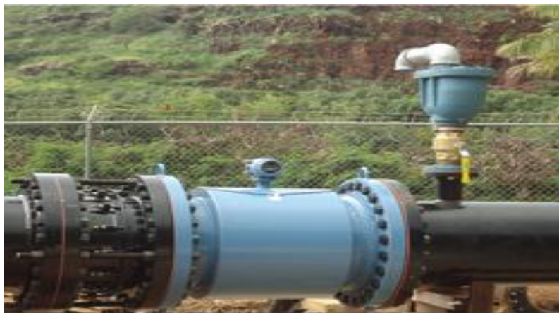
Figure III. 18 Valve à air dans une conduite [17]
