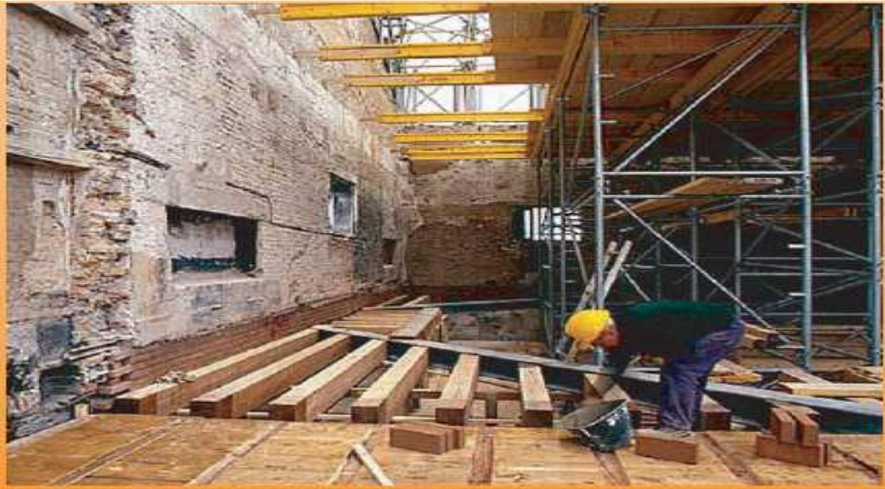
**Figure II.25** : réhabilitation d'un ancien planchers
