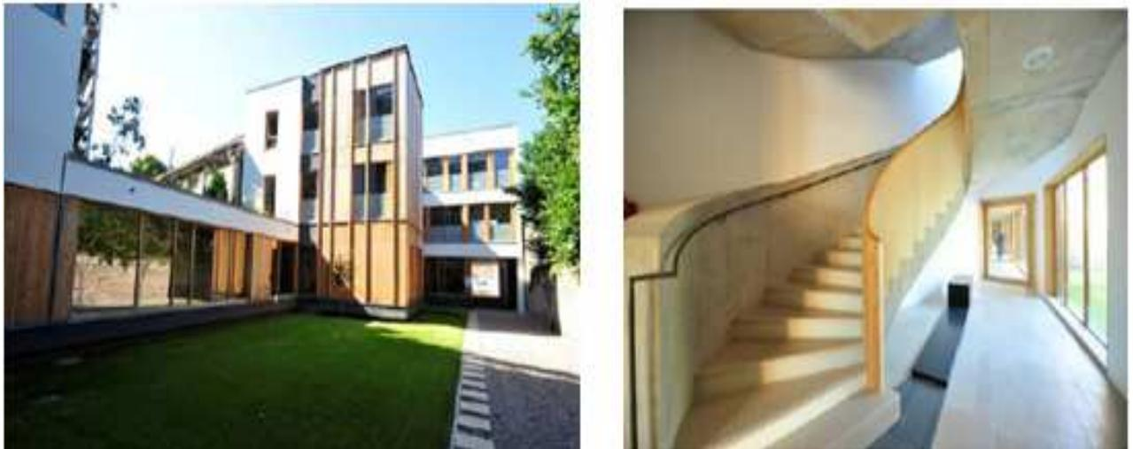
**Figure I.5:** structure publique mixte en bois – béton.
