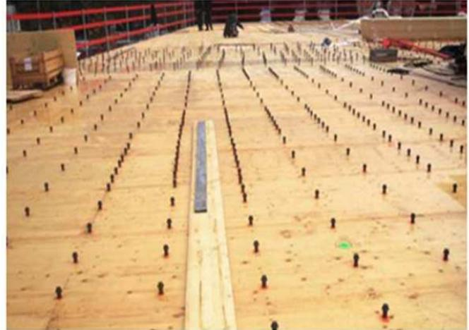
**Figure III.6** : mise en œuvre des connecteurs de type SBB
