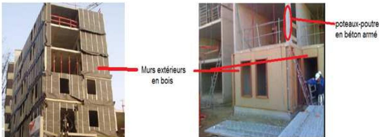
**Figure I.4 :** structure à ossature en béton armé, murs intérieurs et extérieurs en bois
