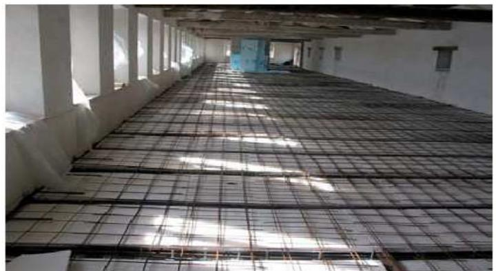
**Figure II.26** : planchers prêt pour le collage
