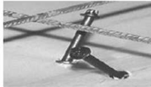
**figure III.10:** mise en place du connecteur SFS VB dans un plancher
