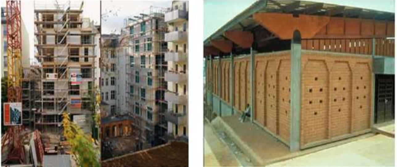
**Figure I.3 :** structure à ossature en béton armé
