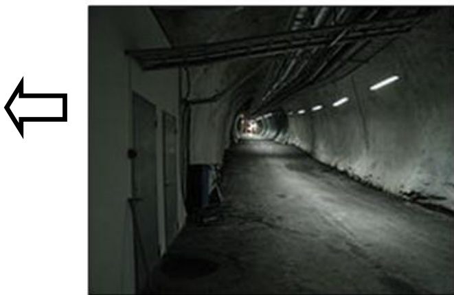
Figure 34: Le long couloir d'accès où on trouve les portes d'accès vers la salle de contrôle ainsi que la salle de maintenance, source: Ramis, 2020
