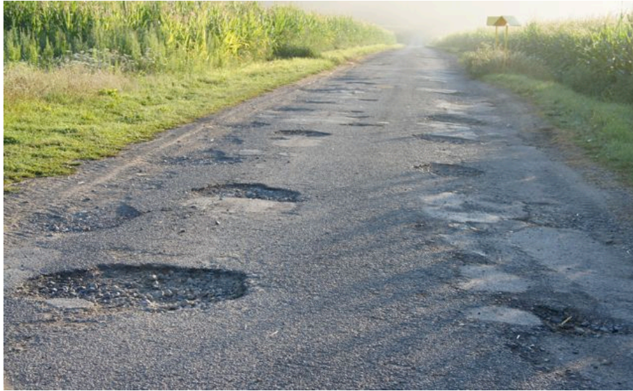
Figure I.8: Reprofilage dans les ornières avec des matériaux bitumineux ou fraisage des bourrelets.
