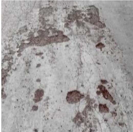
Figure I.10: Dégradation d'arrachement.
