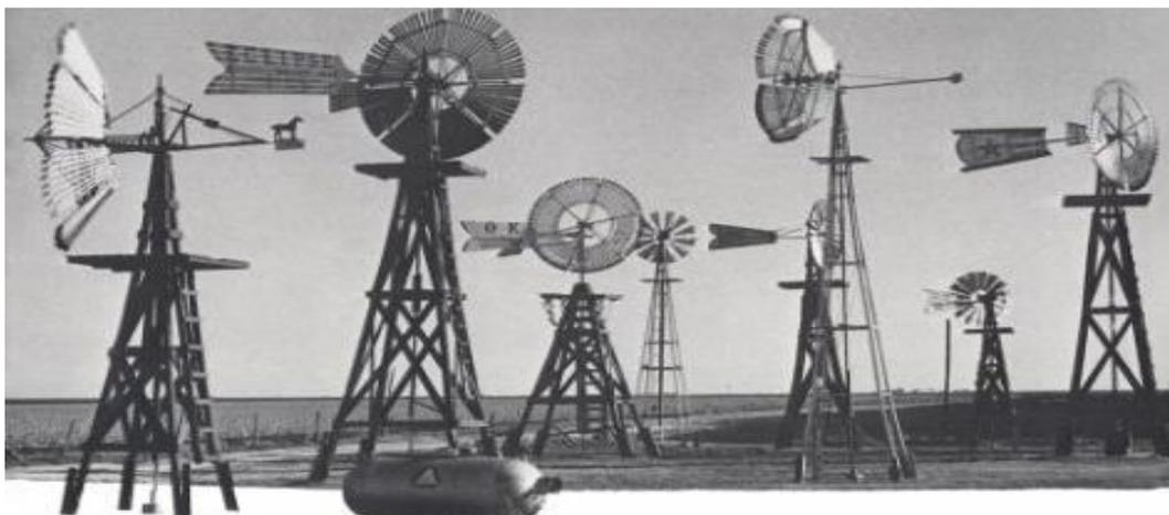
**Figure II.2 : Eolienne lente multiple en Amérique.**
