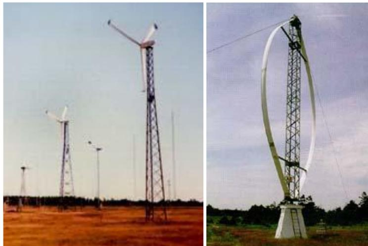
a) Eolienne à axe de rotation horizontal b) Eolienne à axe de rotation vertical
