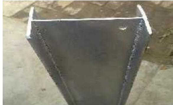
Figure III.47 : photo d'un poteau en IPN
