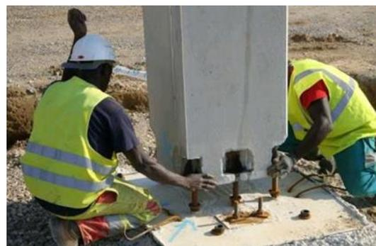
Figure III.52: fixation d'un poteau en B.A préfabriqué Source : <http://Google image.com>
