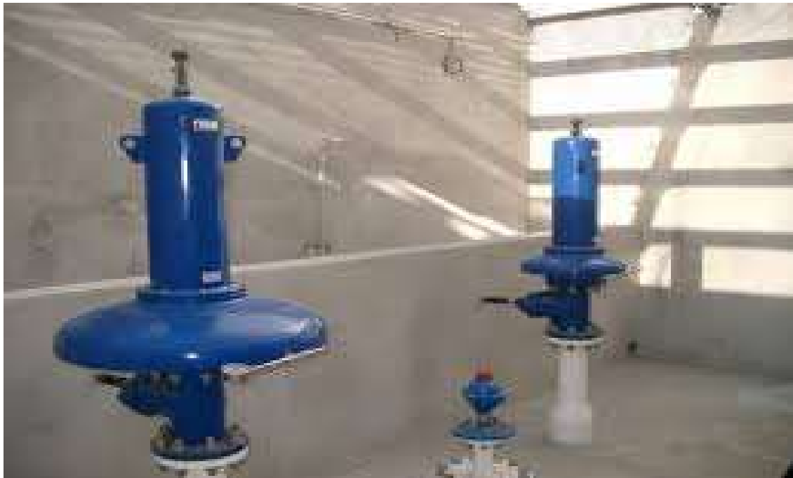
FigureVI-3 : soupape de décharge.
