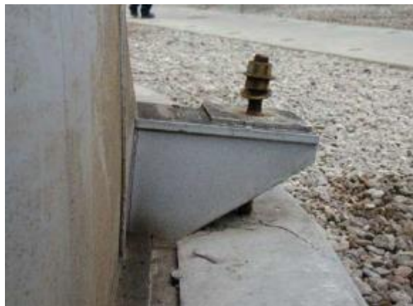
Figure I.2 : ancrage d'un réservoir en acier
