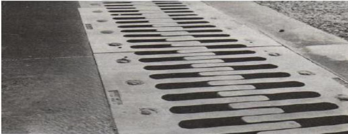
*Figure IX.9: Un type de joint de chaussée*
