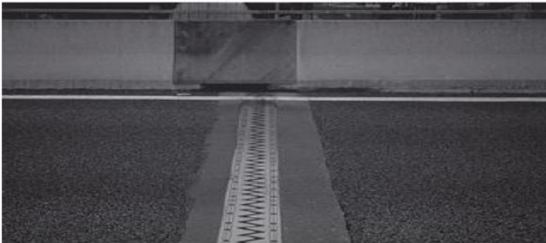
Figure IX.11: Joint du type Wd (souffle moyen)
