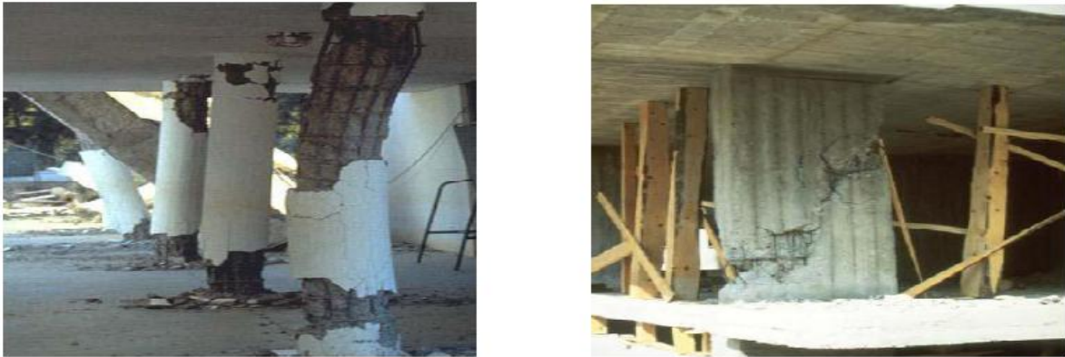
Figure II.12 : Mode de ruine des éléments élancés [27].
