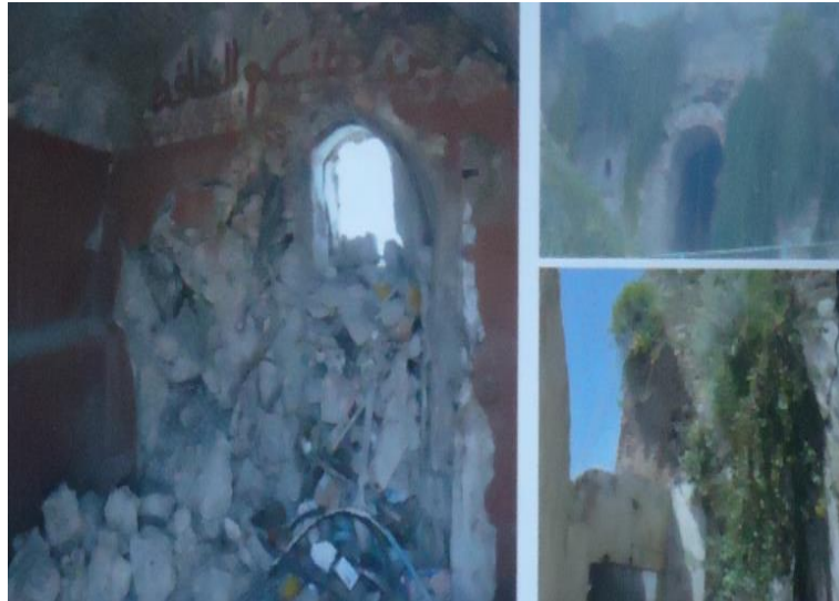
Figure106 : dégradation de fort AEK
