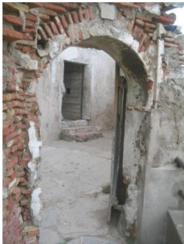
Figure 102 : entrée au fort
