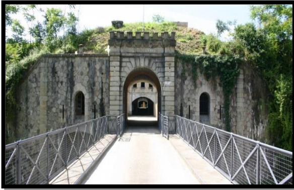
Réhabilitation de pavillon
