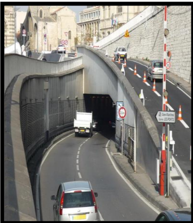
Création du tunnel de la major. Source : routes.wikia.com
