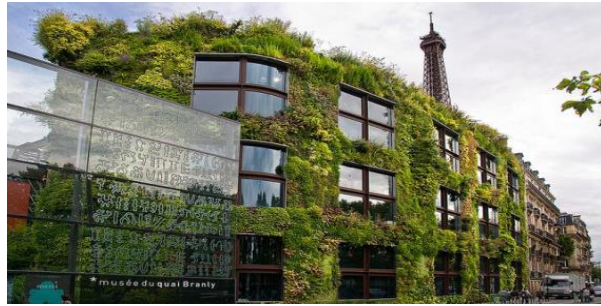
Figure143 : façade du bâtiment Branly
