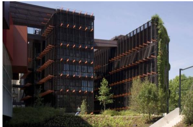
Figure144 : façade bâtiment Auvent
