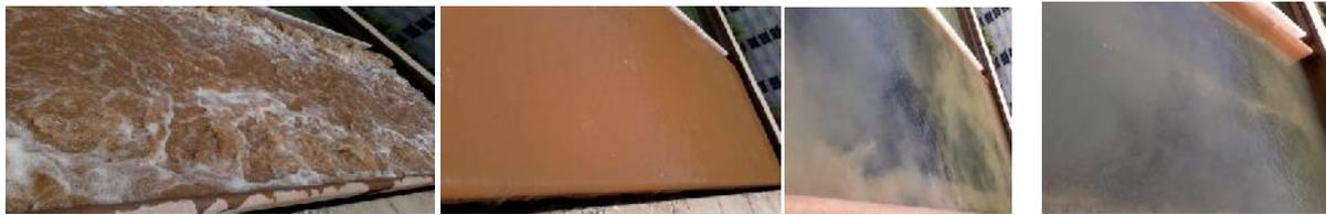
**Figure 12.** Filtre à sable au cours du lavage.
