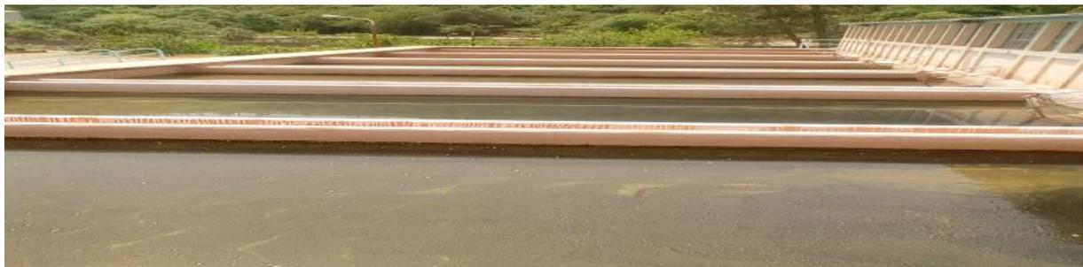
**Figure 11.**..filtres à sable fins.
