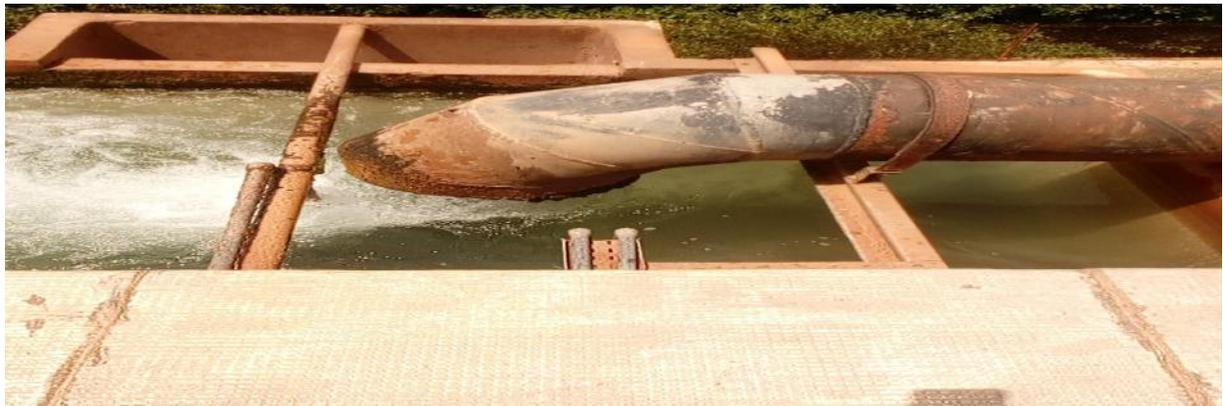
**Figure 10.** Bassin d'injection des réactifs de traitement.
