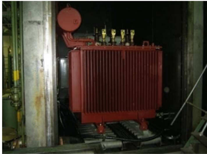
Figure II.9. Remplissage du transformateur
