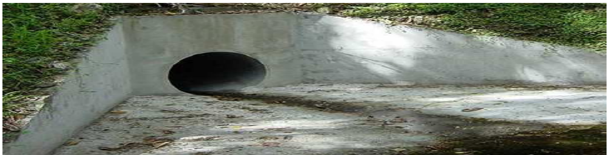
Figure VIII-5 : Système de drainage transversal (buse).
