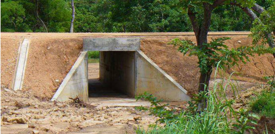
Figure VIII-8 : Un dalot (système de drainage transversal).
