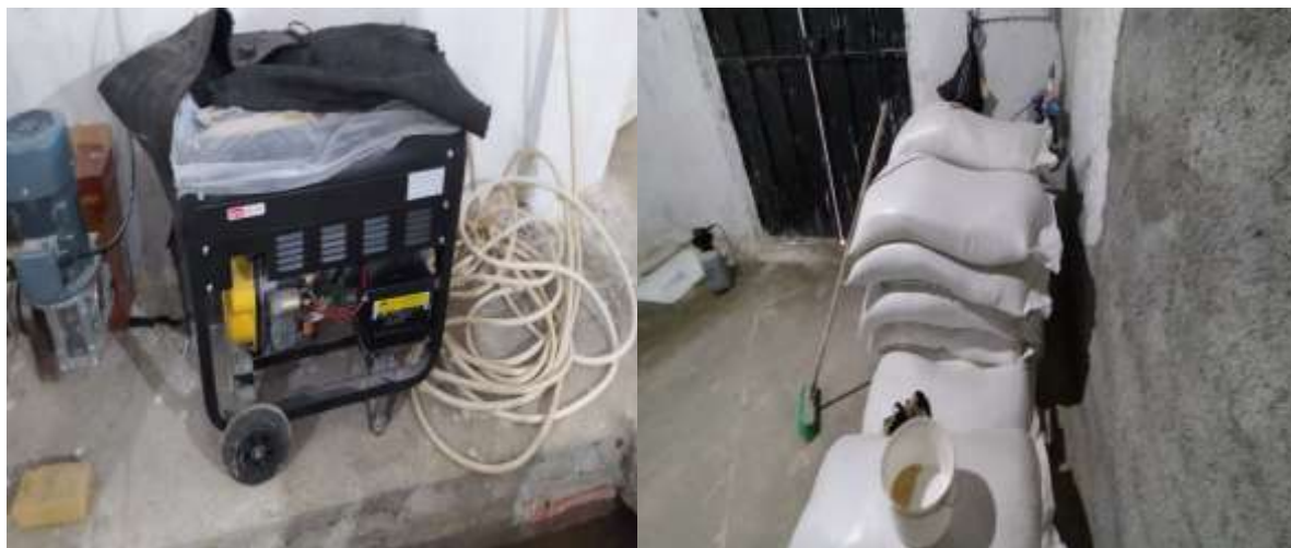
Figure N° 15: Photo de groupe électrogène et le stockage de l'aliment de l'élevage.
