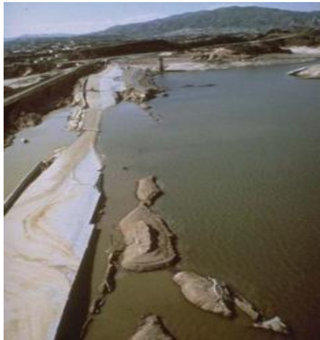
Figure 1.3. Rupture par glissement du barrage inférieur de San Fernando (1971)
