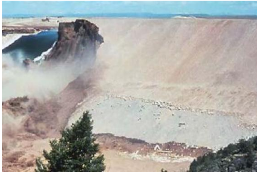
Figure 1.6. Rupture du barrage en terre de Teton (Idaho) en 1976.
