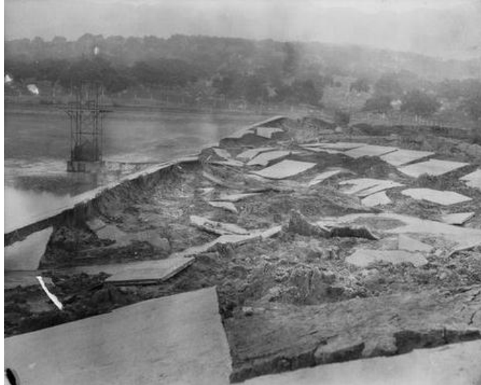
Figure 1.4. Rupture totale du Barrage Sheffield après le séisme de Santa Barbara, 1925.
