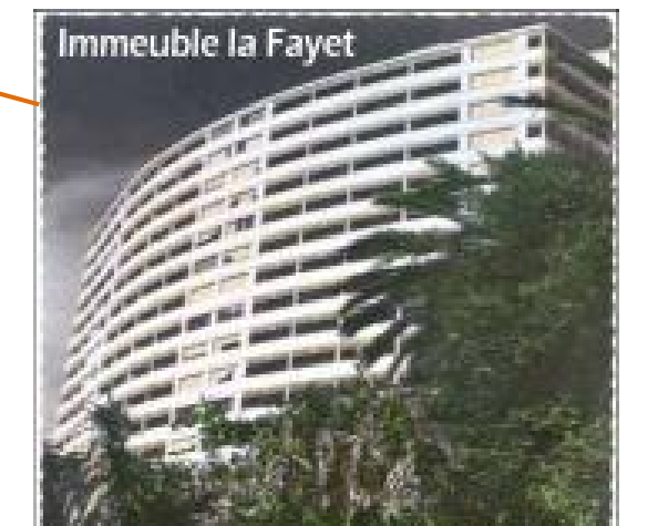
• Immeuble la Fayette.
