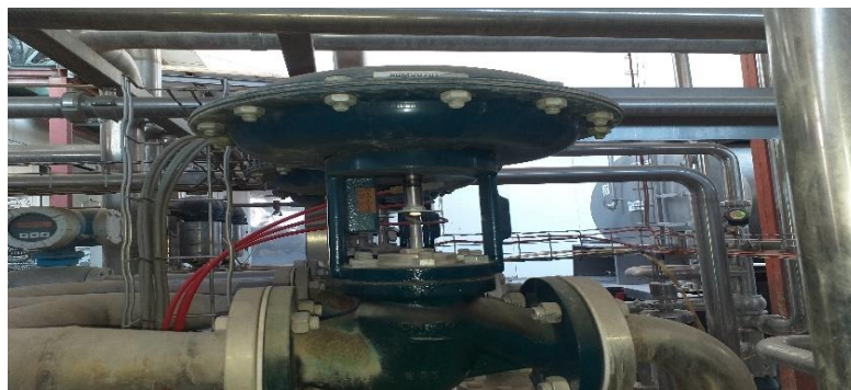
Figure I.4 : Schéma d'une Vanne modulante (régulatrice) [14].
