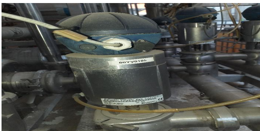
Figure I.5 : Schéma d'une vanne Papillon pneumatique TOR [14].
