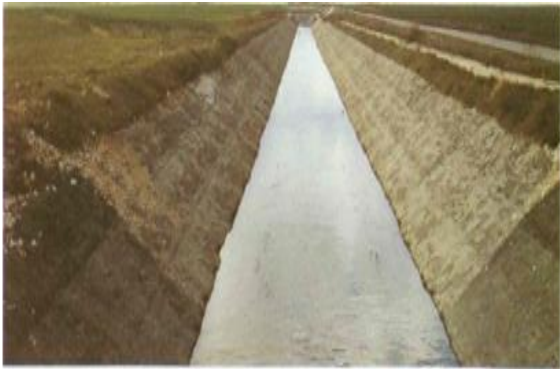
figure 1.10 Canalisation en matelas Reno galvanisés et plastifiés du cervaro, près de son embouchure[2].
