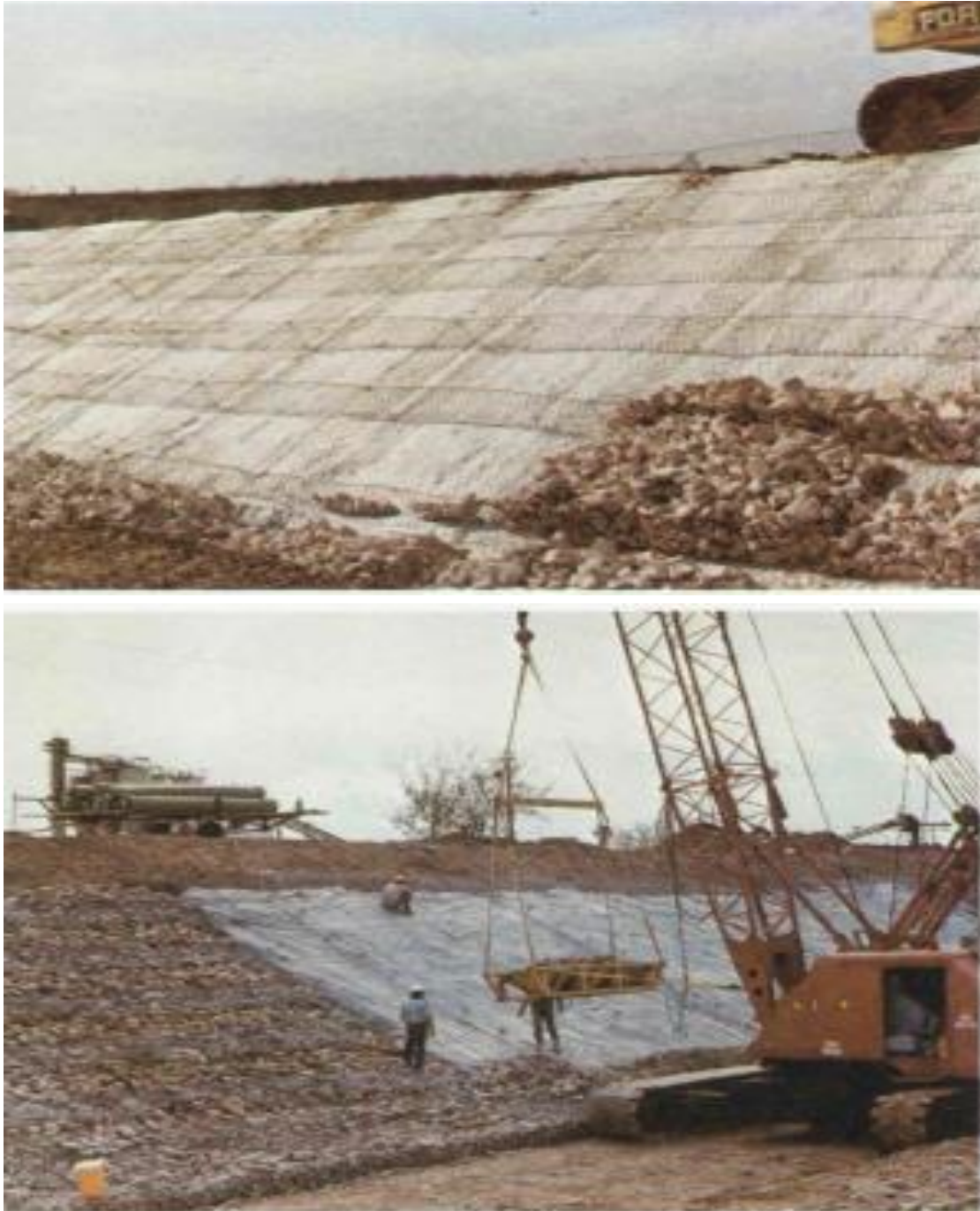
figure1.6 (a;b) mise en place et assemblage des éléments [2].
