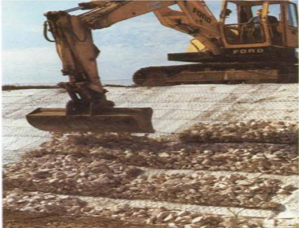
figure 1.7 remplissage des éléments avec des galets des enrochements[2].
