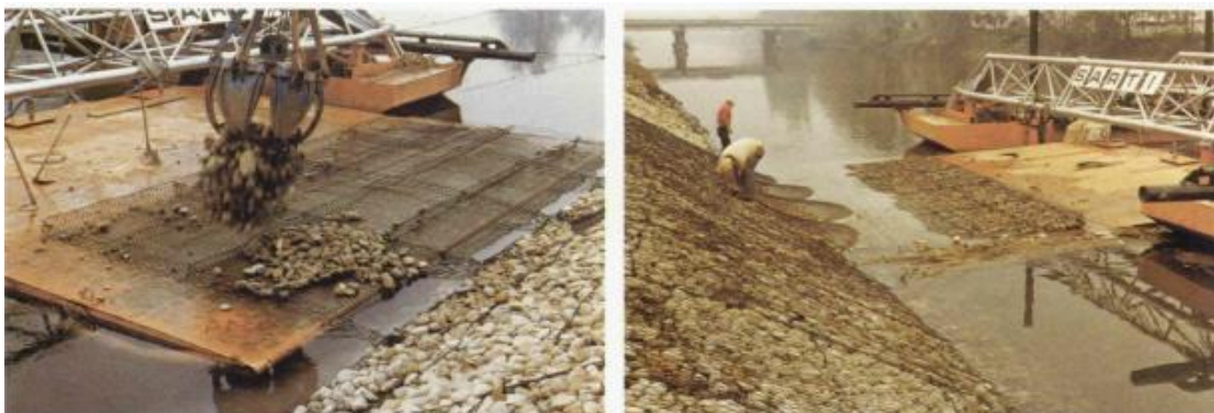
figure 1.11: revêtement en matelas Reno galvanisés et plastifiés en présence d'eau du canal adducteur de la central thermoélectrique de Tavazzano à Mentenase [2].
