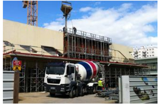
Figure 159: Mise en œuvre de la structure du projet. Source : serero.com/test/projets/meudon
