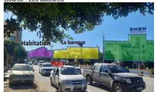
Figure 55 : Photo de Paroi droite de Boulevard Ali Stiti
