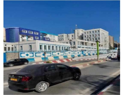
Figure 46 : photo de paroi gauche de 1 er tronçon Source : les auteures
