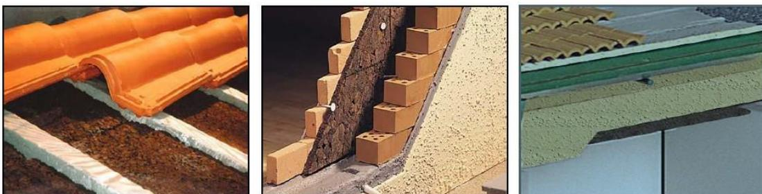
**Figure I.4** : Isolation de la toiture, des murs creux et des toitures et des combles isolés [9]
