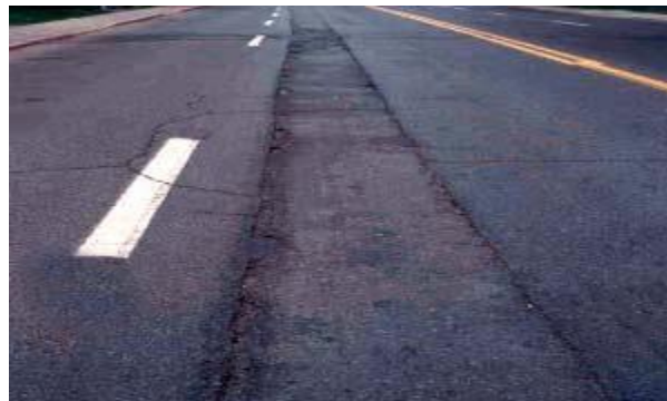
Figure II.11: Coupe et tranchée sur les routes
