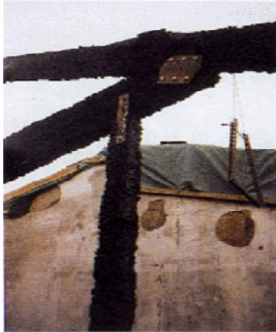
Figure 1-1 Charpente en lamellé-collé après un
