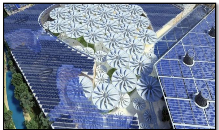
Figure147 : les panneaux solaires
