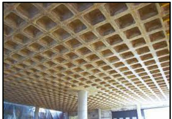
Figure183 : plancher caisson Source : https://www.geoplastglobal.com/
