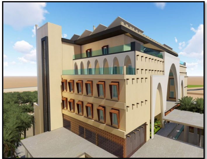
Figure174 : brises solaires du côté ouest. Source : auteur
