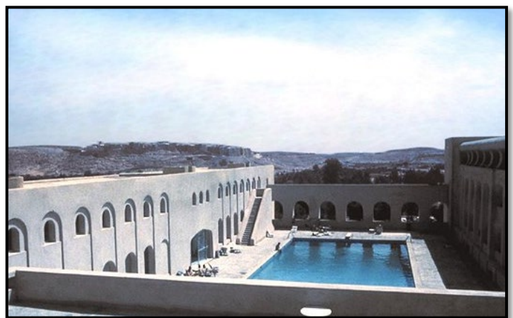
Figure122 : Hôtel du Mzab Source : https://www.fernandpouillon.com/mzabarchp.html
