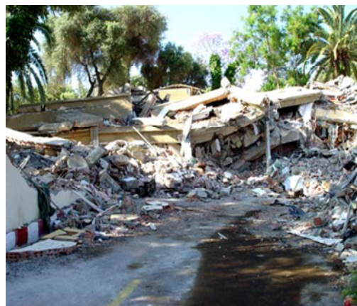
Effondrement total d'un bâtiment de 5 (?) étages
