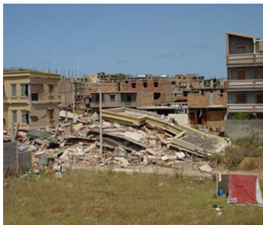
Effondrement total d'un bâtiment de 3 étages
