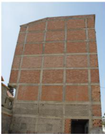
Figure 14. Portique avec remplissage en maçonnerie.
