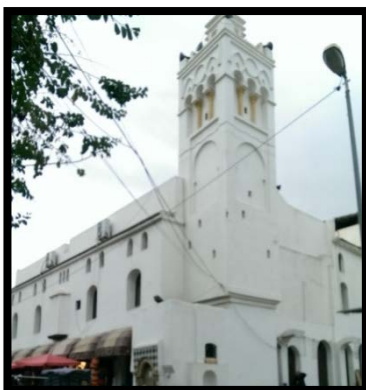
FIG 49 : la mosquée Ali Bitchine
