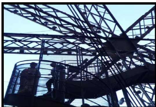
FIG 149 : les poutres à tréllis
