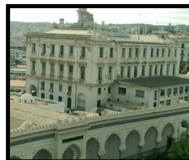
FIG 54 : la chambre de commerce
