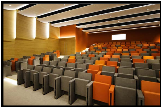
FIG 162: le plafond d'un auditorium
