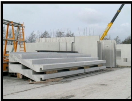
FIG 152 : gradin préfabriqué en béton armé
