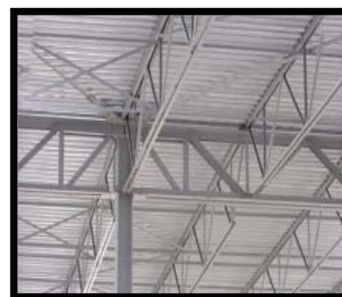
FIG 131 : poutre à treillis
