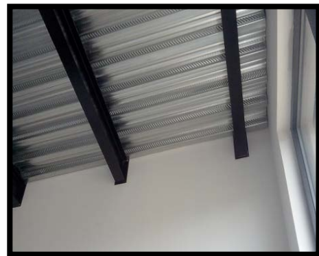
FIG 133 : vue du plancher de l'intérieur
