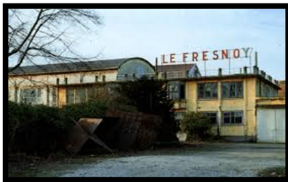
FIG 84: le projet avant sa réhabilitation
