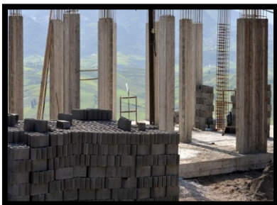
FIG 127 : poteaux en béton armé
