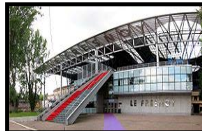
FIG 85 : le projet après sa réhabilitation
