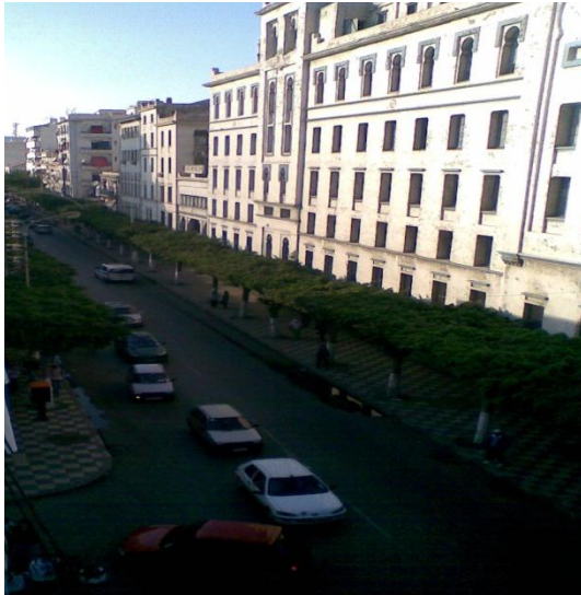
Figure 18: La rue Tripoli avant l'installation de la ligne de tramway.
