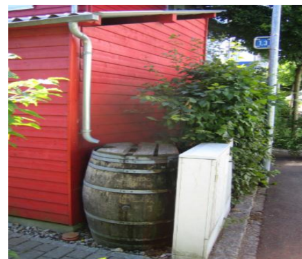
Figure2 : Citernes récupérés des eaux pluviales
