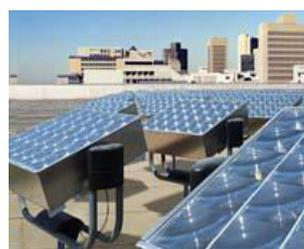
Figure (I-43) : Cellules à concentration utilisant des lentilles de Fresnel de Energy Innovations [79].
