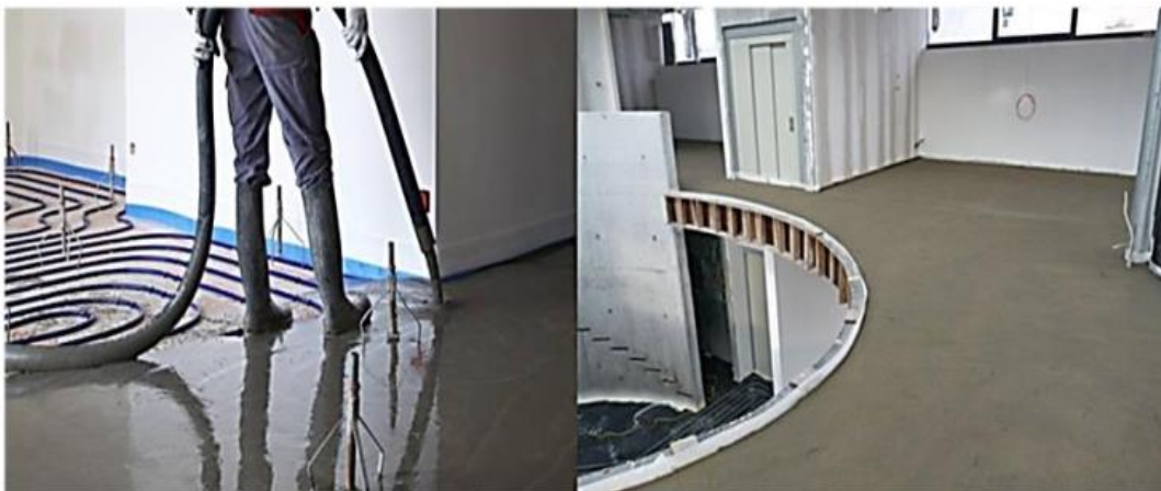
Figure I. 8 : Les chapes fluides et chape ciment.
