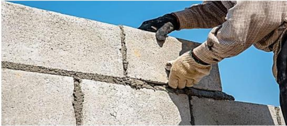
Figure I. 7 : Pose de mortier de maçonnerie.
