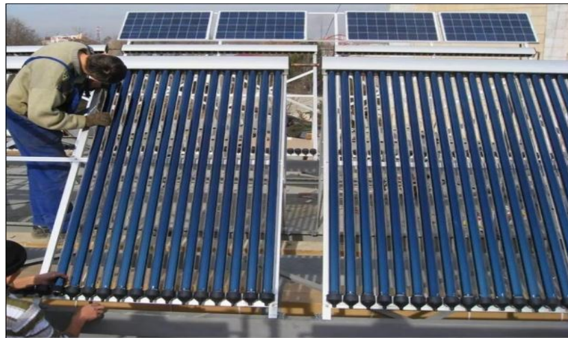
Figure II.10 Capteur tubulaire sous vide [24].
