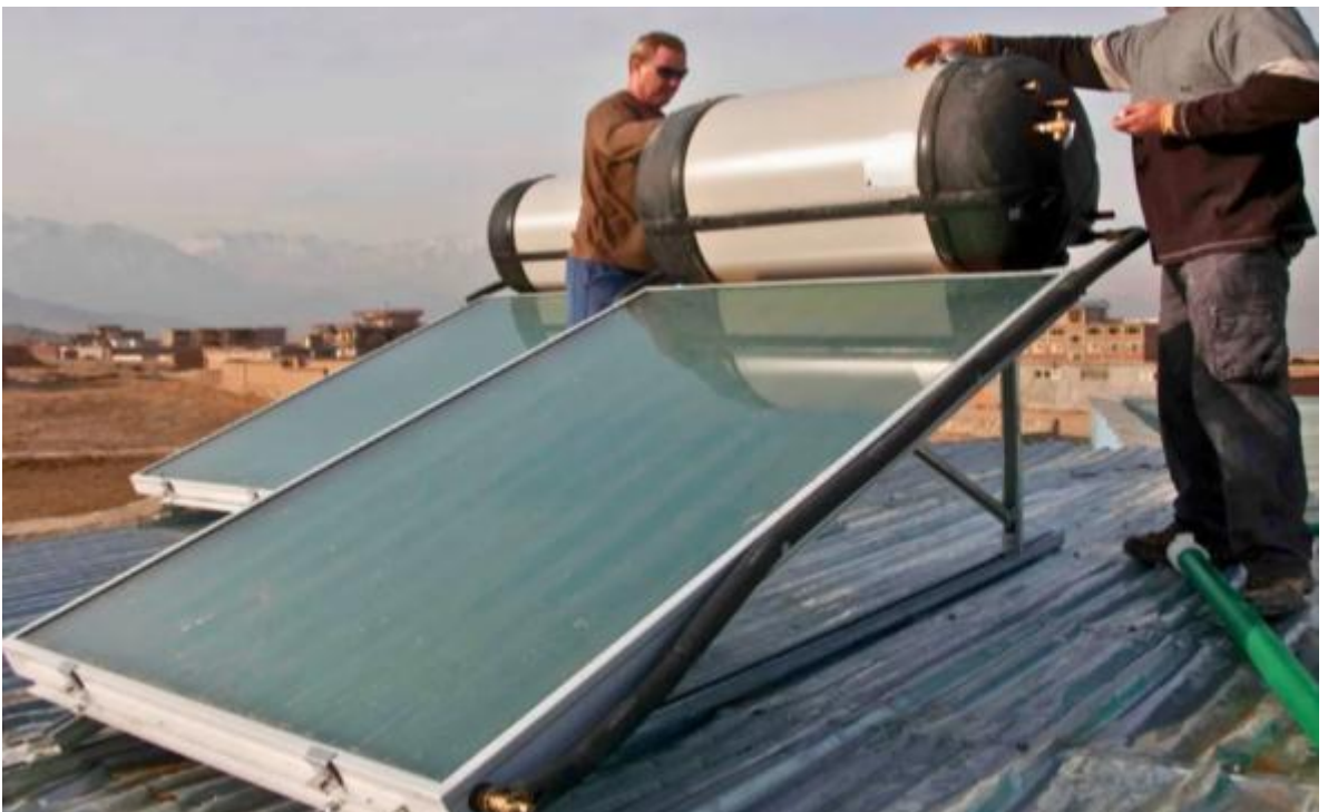
Figure II.11 Capteur solaire plan vitré [24]
