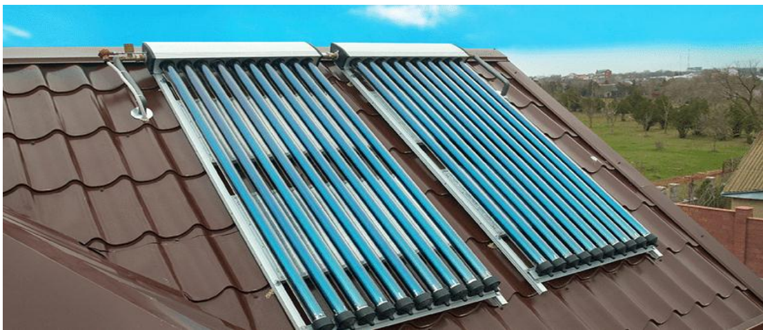
Figure II. 9 Capteur solaire thermique à tubes sous vide (caloduc) [24].
