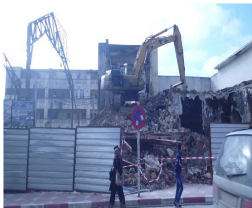
Figure II.12 : Démolition du cinéma Djurdjura de Tizi-Ouzou.
