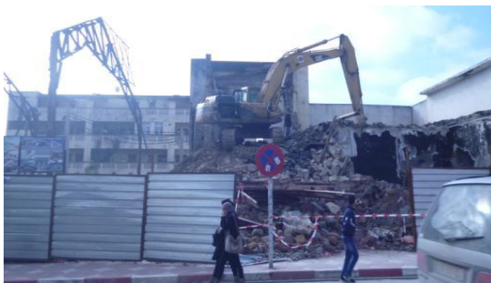
Figure III.15 : Démolition du cinéma Djurdjura
