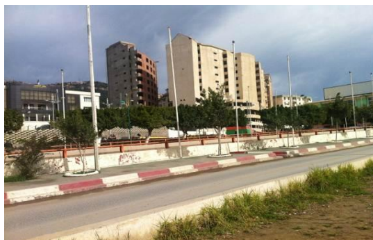
Figure V.08: Les trémies. Source: Auteurs.
