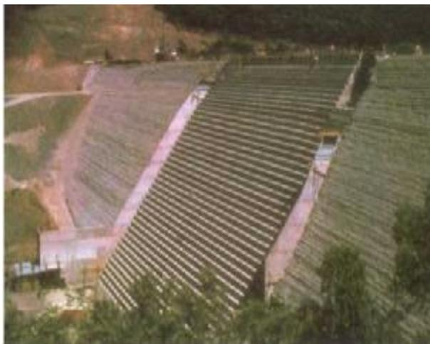
**Figure 8** : Barrage poids en BCR des Olivettes (France) (H=35m) (technique de l'ingénieur)
