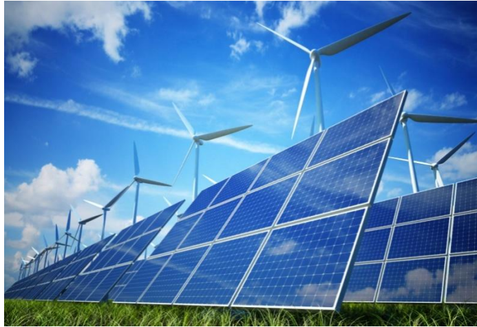
Figure I.21 : Système hybride (photovoltaïque - éolienne).
