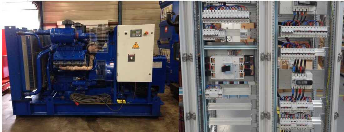
Figure I.10 : groupe électrogène Figure I.11 : tableau TGBT
