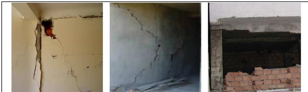
Figure 2.4. Effondrement et fissures importantes dans les cloisons intérieures et extérieures
