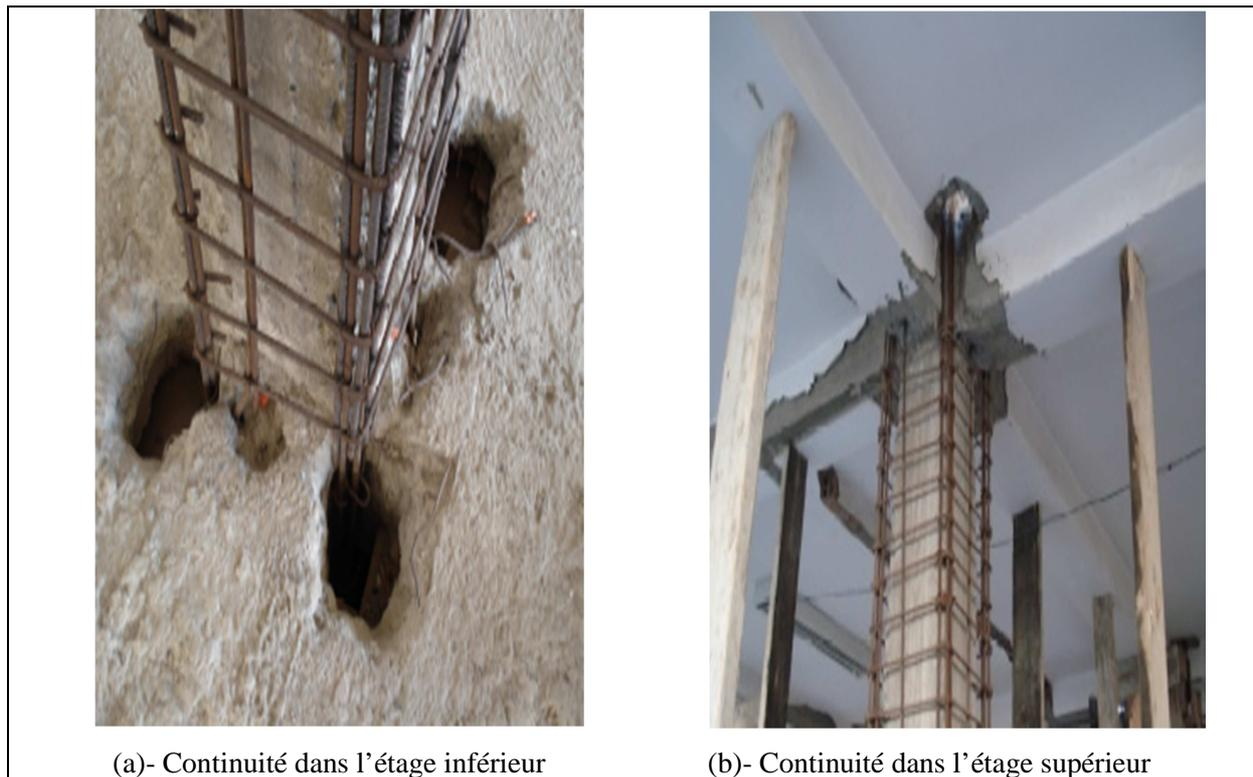
**Figure 1.7.** Continuité des armatures de renforcement dans les parties communes inférieure et supérieure d'un poteau en béton armé [Boukais S. 2011].
