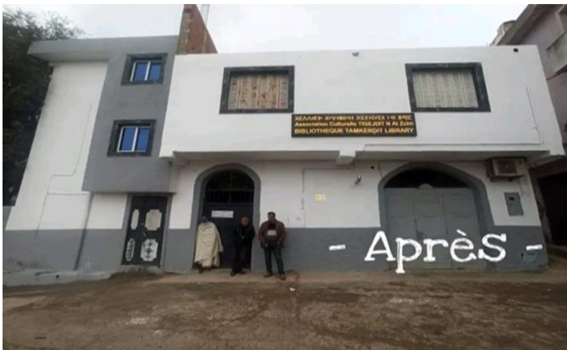
Photo 3 et 4 : La bibliothèque avant et après rénovation
