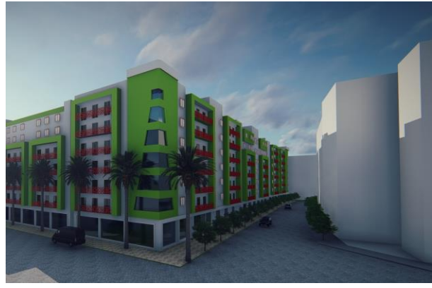
Figure137 :la rue de dey après l'intervention Source : l'auteur.
