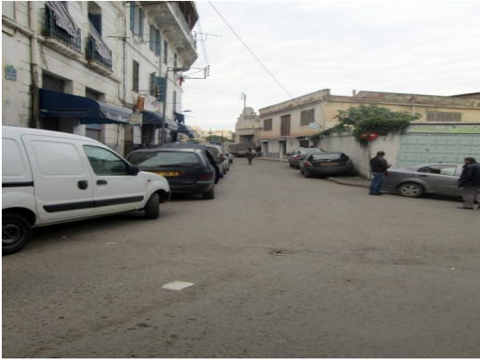
Figure136 :la rue de dey avant l'intervention Source : images prises par l'auteur.
