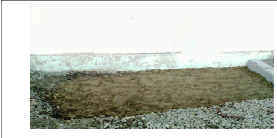
Figure 12 : plateforme préparée pour le compostage
