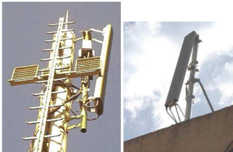
**Fig V.4.4 :** Antenne directionnelle avec tilt négatif antenne directionnelle avec tilt positif.
